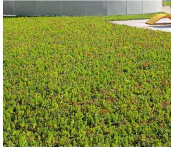
Sedum spp. Green Roof Sedum Mix
